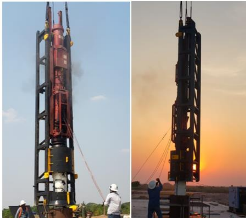
Figura 1. Hincado de tubería conductora con martillo diésel
