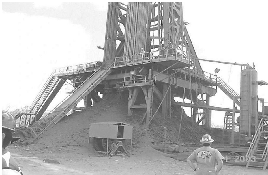
Imagen 4. Blow Out durante la perforación del hoyo intermedio en el campo San Joaquín
