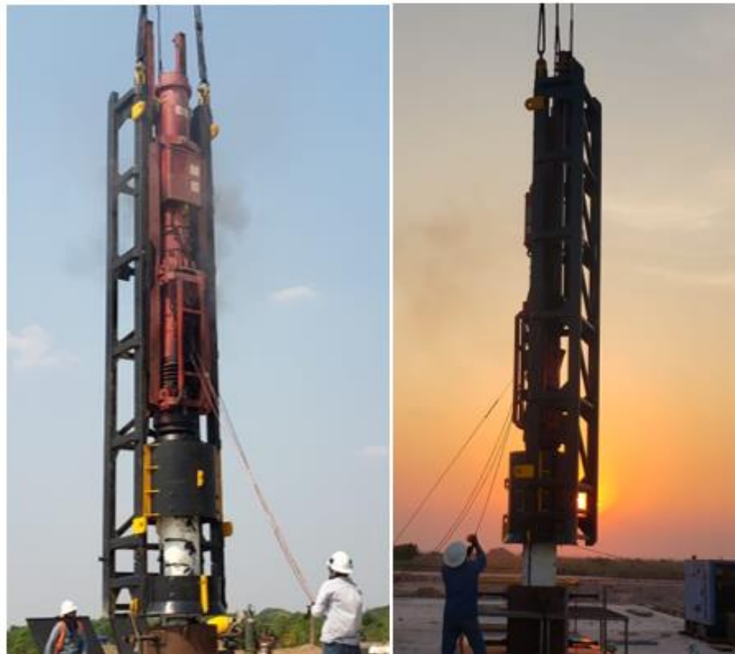
Figura 1. Hincado de tubería conductora con martillo diésel
